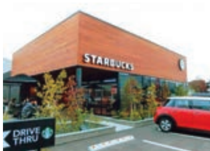
豊橋市 スターバックスコーヒー豊橋柱店
